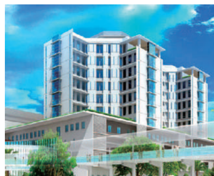
※2016年4月新築移転のため外観はイメージです。
