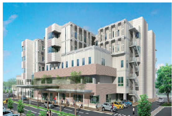
*2016年10月新築移転のため外観はイメージです
